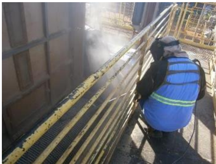
Figura 19 - Soldador realizando atividade com rotação do tronco e flexão do pescoço, atividade em posição agachada
