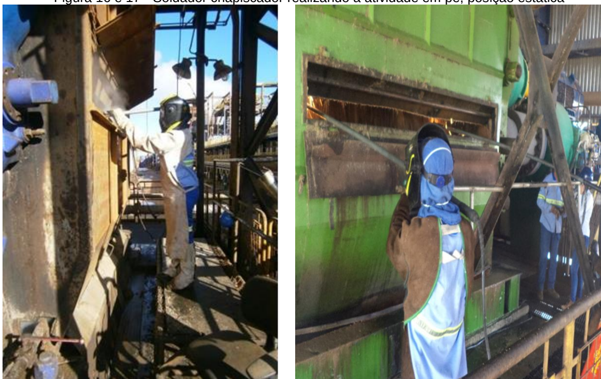
Figura 16 e 17 - Soldador chapiscador realizando a atividade em pé, posição estática
