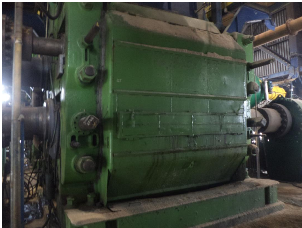
Figura 4 - suporte de proteção da Moenda
