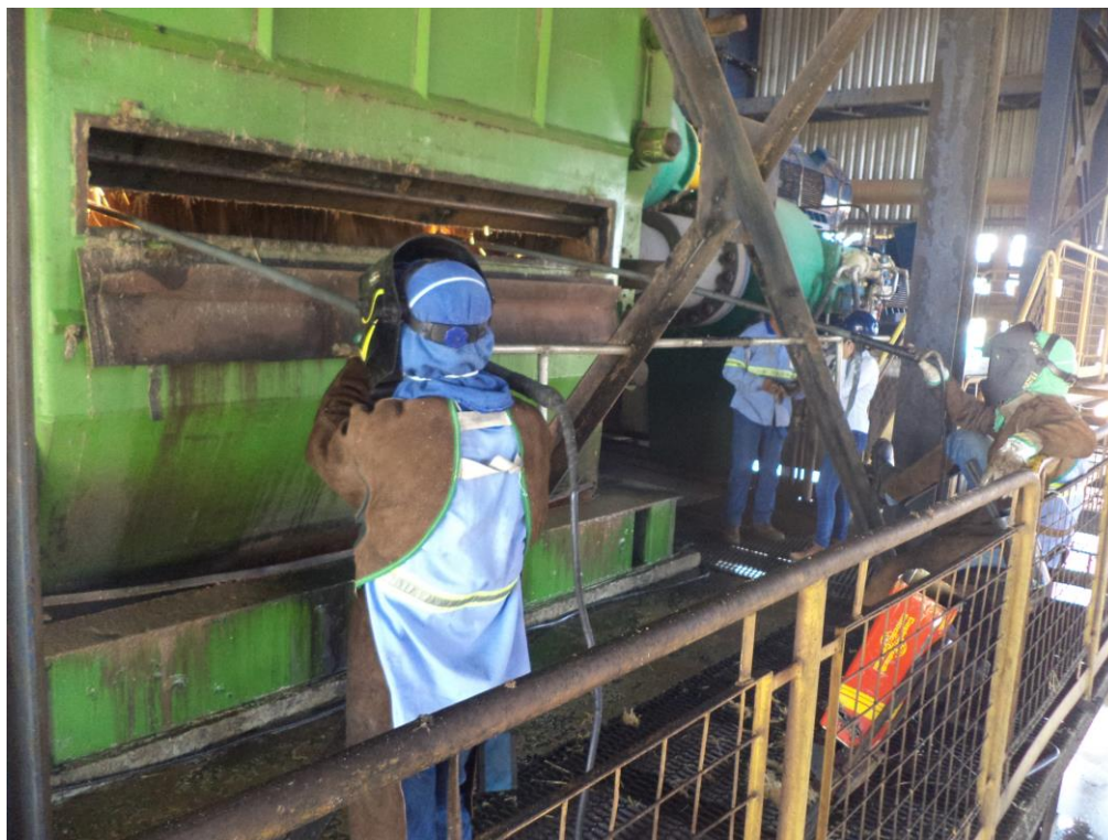
Figura 18 - Soldadores realizando atividade em pé e outro sentado em banco de madeira, sem encosto para as costas e descanso para os pés
